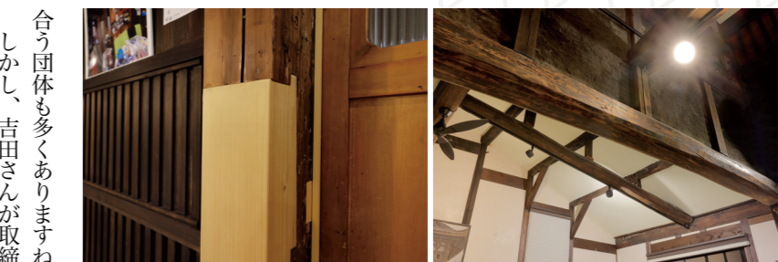
傷んだ部分だけを丁寧に切り取り、新しい木材を継ぎ足して再生した柱（写真左）と、当時の梁をそのまま生かし、趣のある表情を残した梁天井（写真右）。伝統的な自然素材だけではなく、耐震技術と最新鋭の素材も生かしたリノベーションで、暖かく快適な空間に
